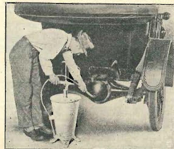
Secchiello-pompa per dispensare lubrificanti freschi e svecchiare quelli sporchi.
